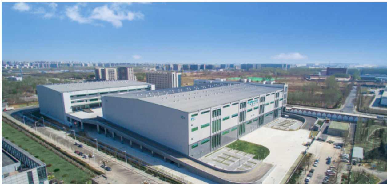
安博北京首都机场第二物流中心
