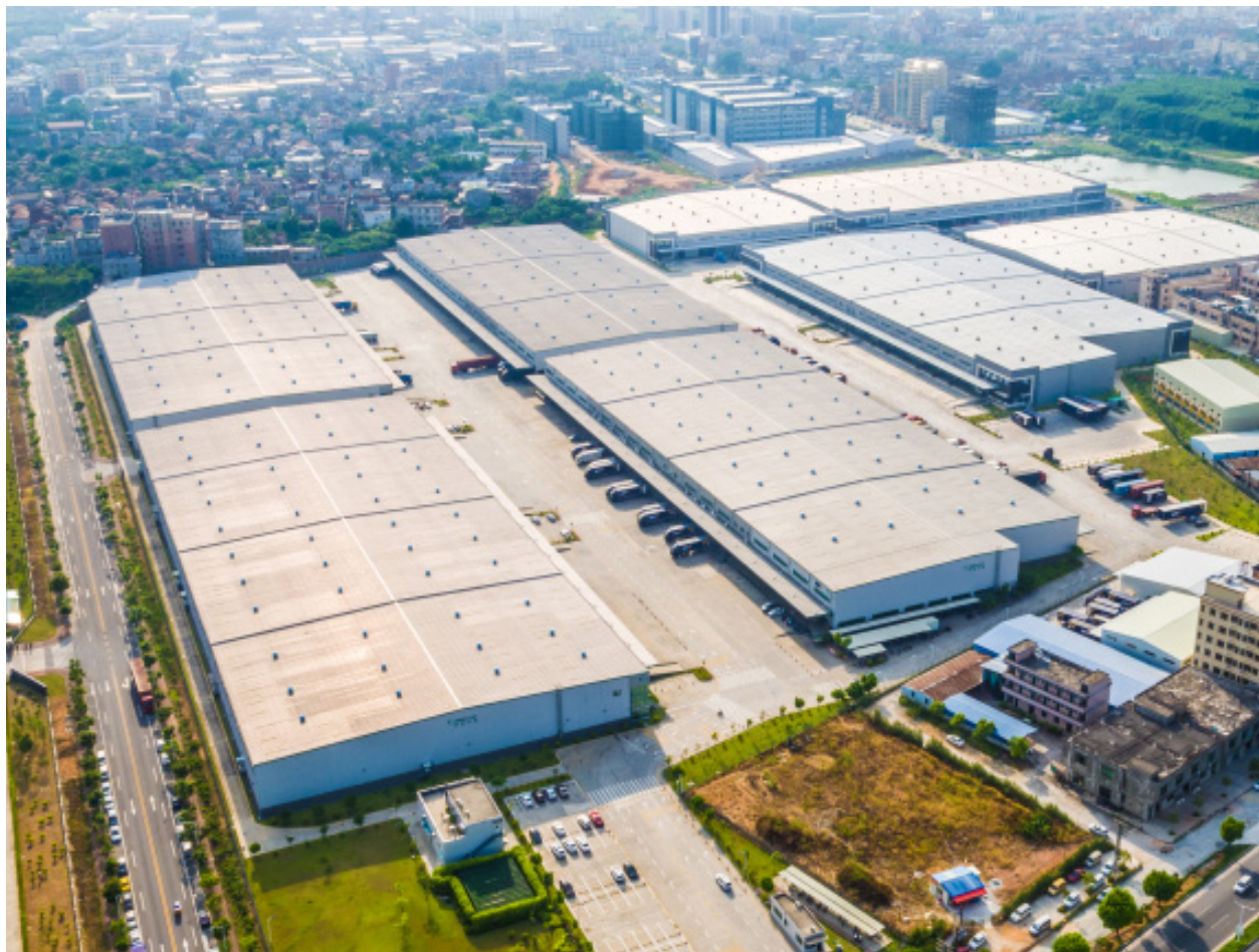
安博东莞石排物流中心
