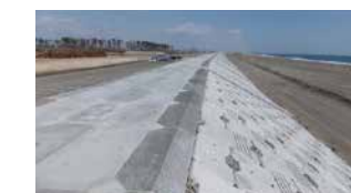
仙台湾南部海岸の堤防
