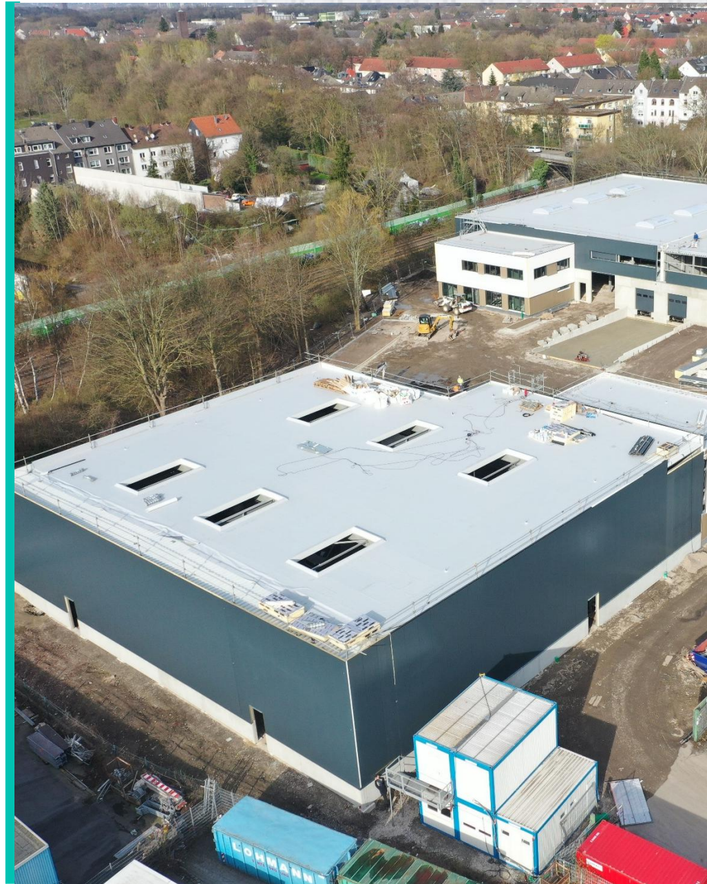
Baustellenfoto von März 2026
